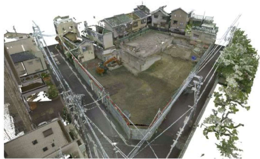
点群データ状況
