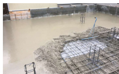
コンクリート工事
