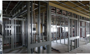
内装仕上工事
