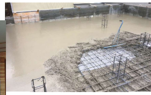
コンクリート工事
